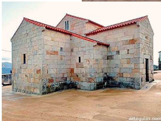
Fotografía 4. La iglesia después de la restauración
