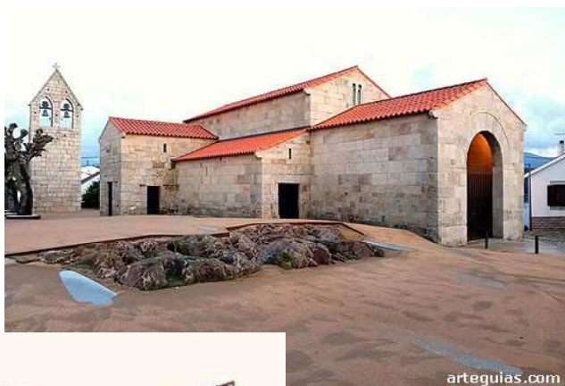
Fotografía 3. La iglesia después de la restauración. Al fondo la torre actual
