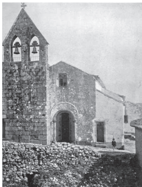
Fig. 1. Antes de la restauración de la Iglesia. Fachada principal.
